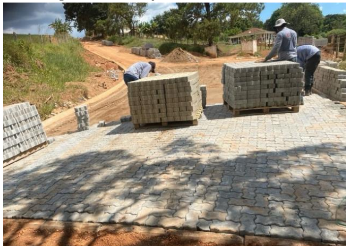
Imagem 30 Pavimentação intertravada (Bairro Pontes)
