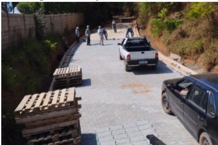
Imagem 33 Pavimentação intertravada (Bairro Pontes)
