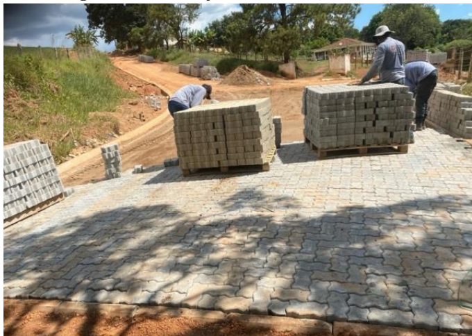
Imagem 30 Pavimentação intertravada (Bairro Pontes)
