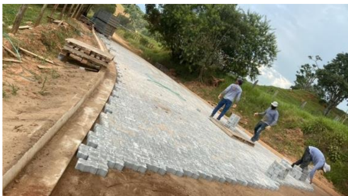
Imagem 31 Pavimentação intertravada (Bairro Pontes)
