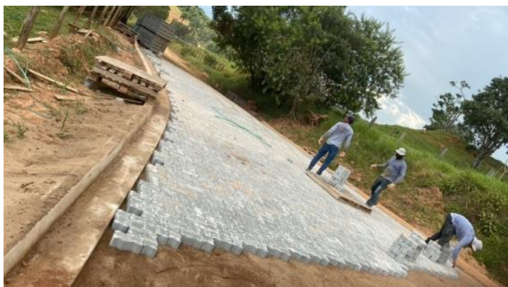
Imagem 31 Pavimentação intertravada (Bairro Pontes)
