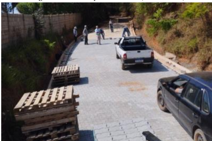
Imagem 24 Pavimentação intertravada (Bairro Pontes)
