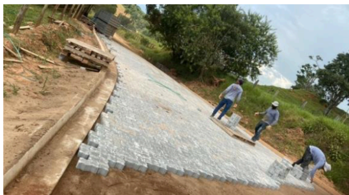
Imagem 22 Pavimentação intertravada (Bairro Pontes)
