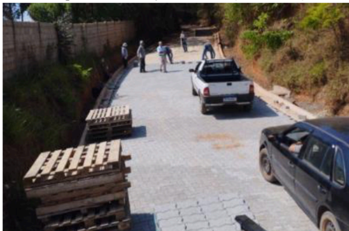
Imagem 24 Pavimentação intertravada (Bairro Pontes)
