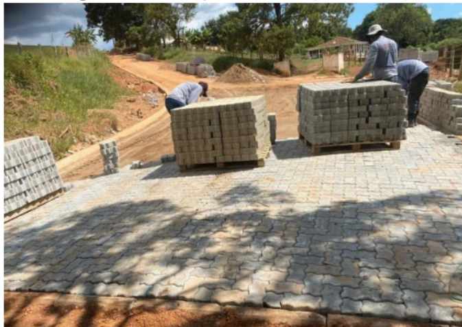
Imagem 21 Pavimentação intertravada (Bairro Pontes)
