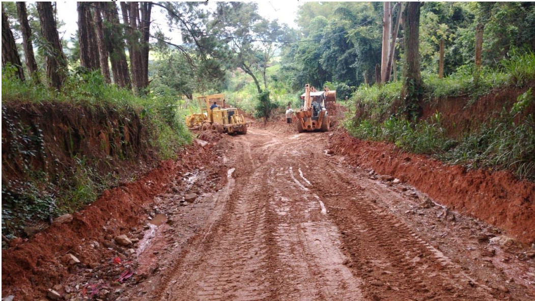
Imagem 23 Manutenção das estradas (Bairro Rio das Pedras)
