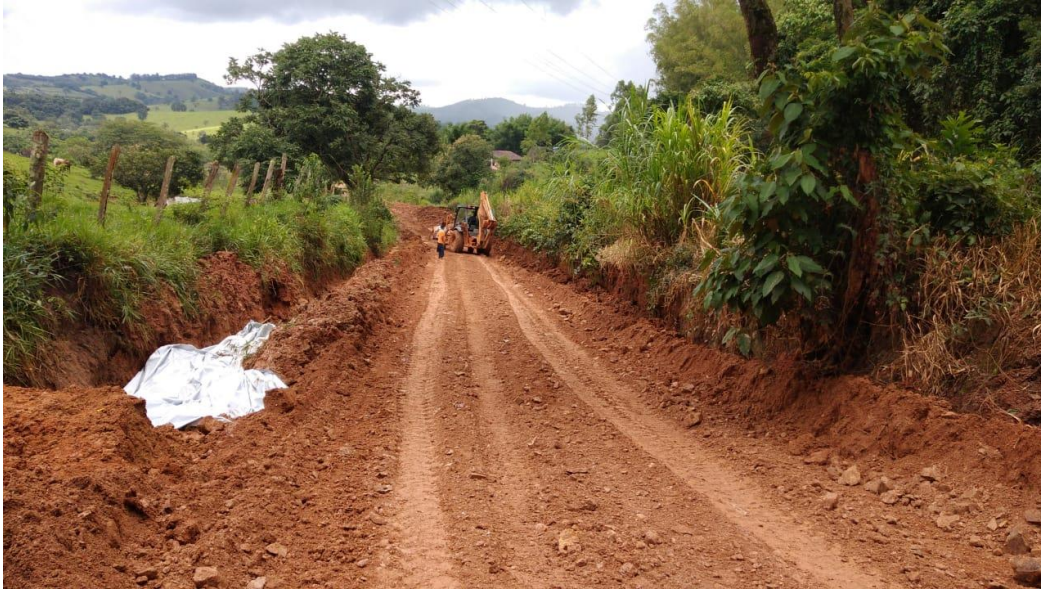
Imagem 24 Manutenção das estradas (Bairro Rio das Pedras)
