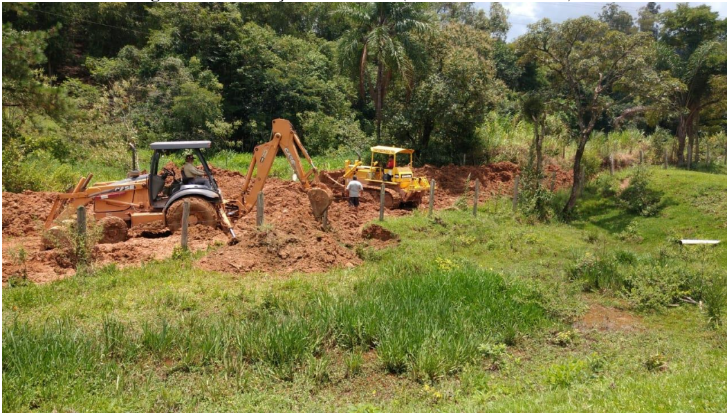
Imagem 22 Manutenção das estradas (Bairro Rio das Pedras)
