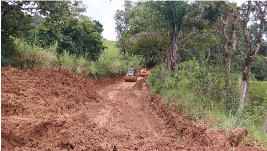
Imagem 25 Manutenção das estradas (Bairro Rio das Pedras)
