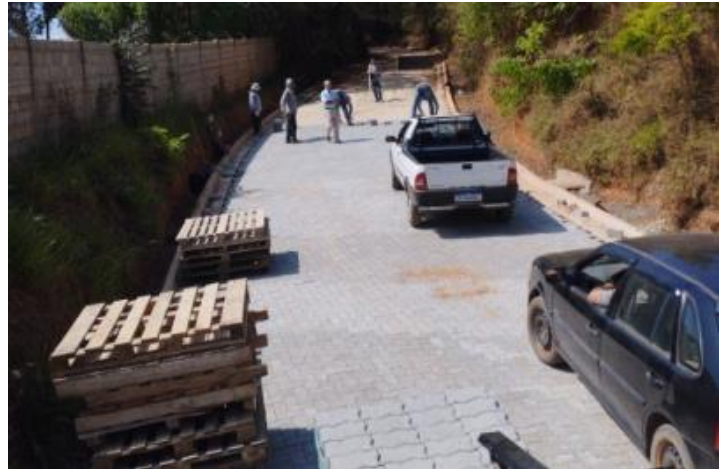
Imagem 33 Pavimentação intertravada (Bairro Pontes)
