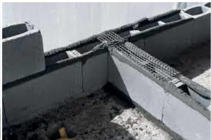
junção da alvenaria nova sem pilar
