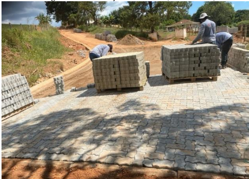
Imagem 17 Pavimentação intertravada (Bairro Pontes)
