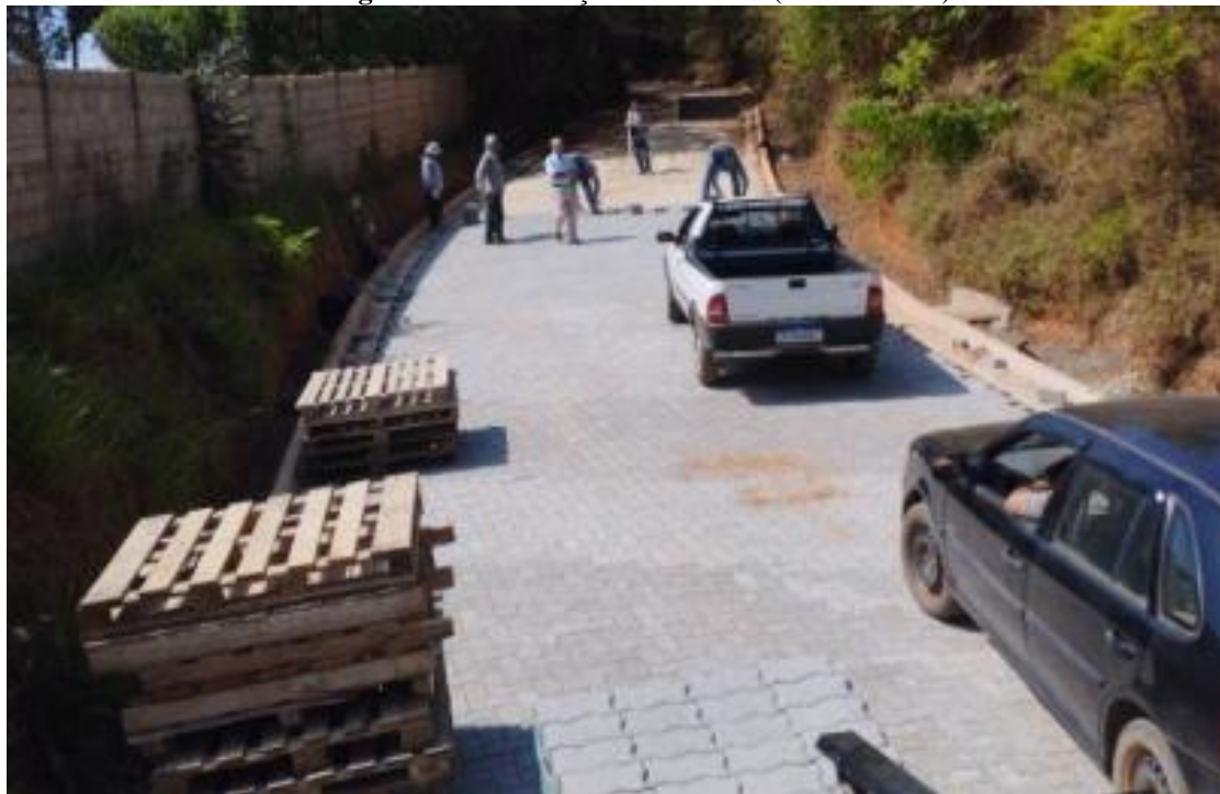
Imagem 20 Pavimentação intertravada (Bairro Pontes)
