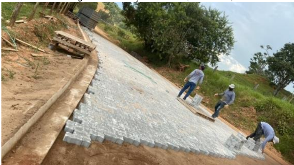
Imagem 18 Pavimentação intertravada (Bairro Pontes)
