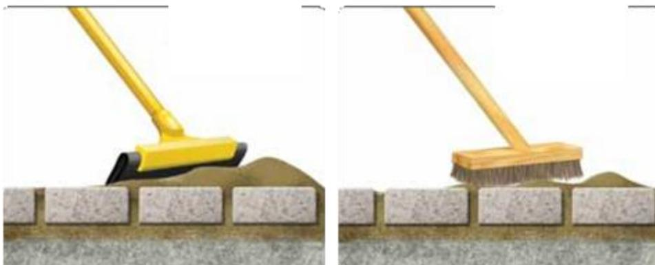
Espalhe a pó de pedra sem deixar formar montes. A pó de pedra para preenchimento das juntas deve ser espalhada sobre os blocos de concreto, formando uma camada de espessura delgada e uniforme, capaz de cobrir toda a área pavimentada; deve-se evitar a formação de montes.
